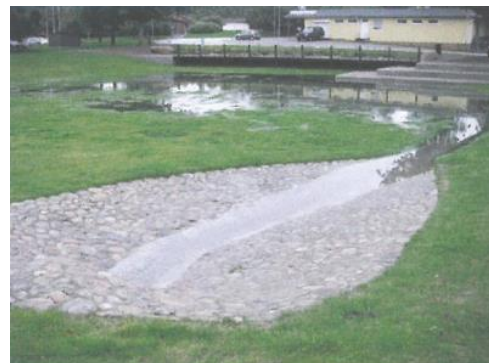
Figur 10. Öppet fördröjningsmagasin, tomt till vänster och med vattenspegel till höger. (Publikation P105)
