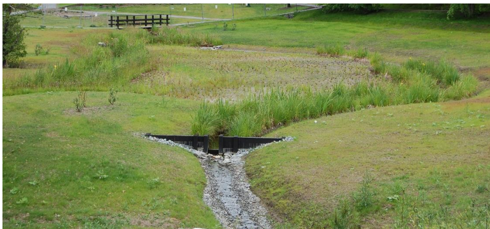
Figur 11. Dike med trappning/strykning av flöde (vegtech.se)
