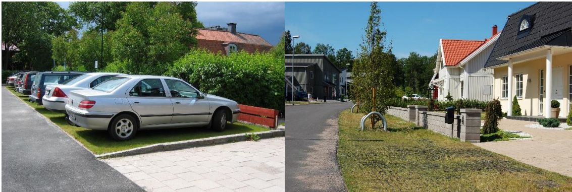
Figur 4. Markarmering, Pelleplatta fylld med gräs. ( www.vegtech.se )
