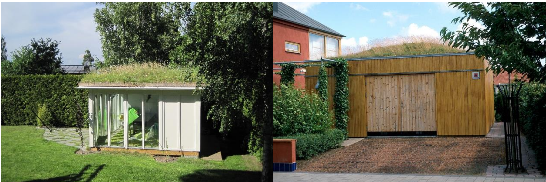
Figur 7. Sedumtak-ört-grästak på uterum och garage. ( www.vegtech.se )
