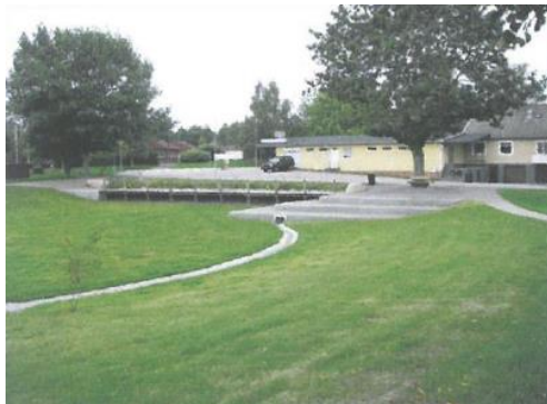
Figur 10. Öppet fördröjningsmagasin, tomt till vänster och med vattenspegel till höger. (Publikation P105)
